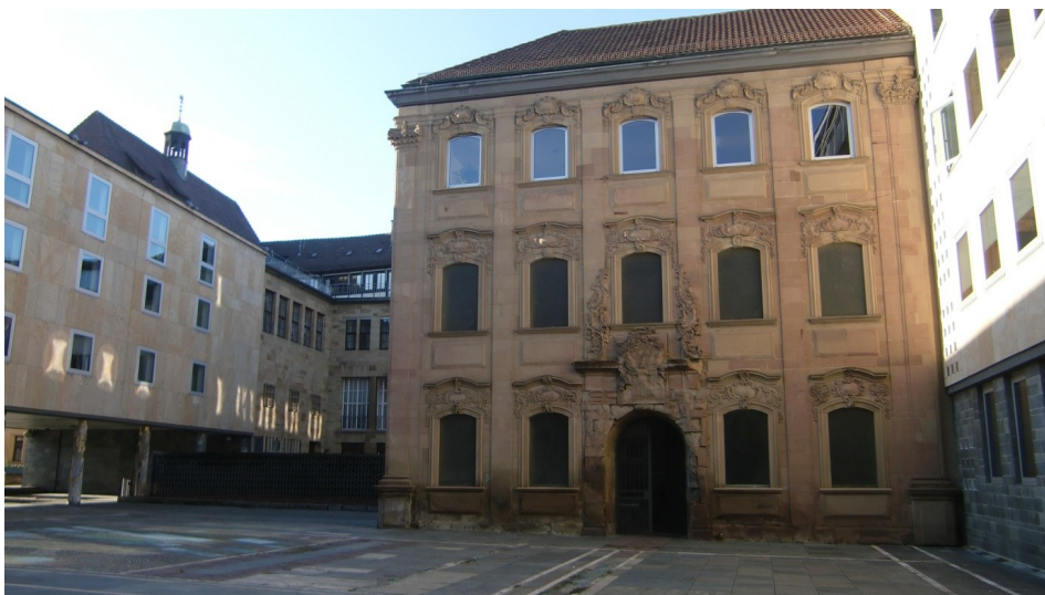
B2 Hinter der Fassade des am 4. Dezember 1944 ausgebrannten Archivs befindet sich die Ehrenhalle der Stadt Heilbronn (Foto: Ulrich Maier)
