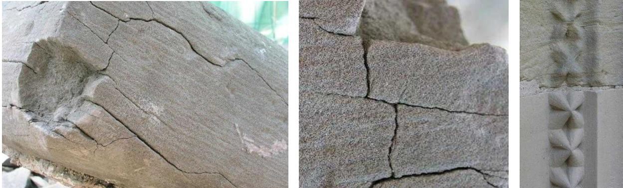
Die Sandkörner sind mit tonigem Bindemittel verklebt, daher ist dieser Sandstein leicht zu bearbeiten, aber auch anfällig für Verwitterung. Im rechten Bild unten erkennt man, dass ein Teil des Mauerwerks mit neuem Naturstein restauriert wurde.
