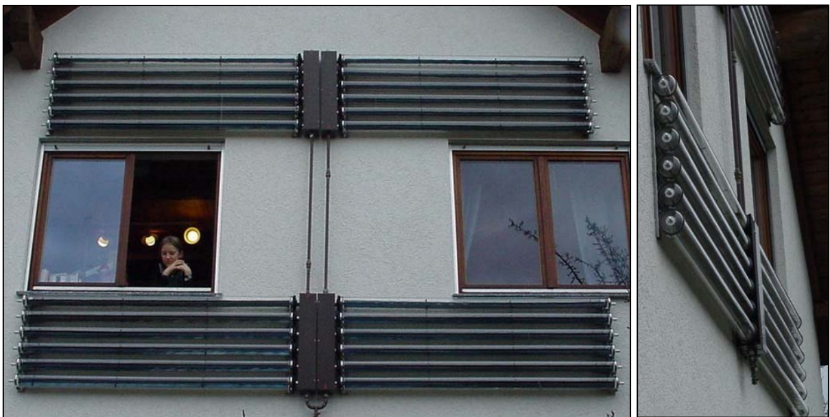
Ein Vakuum-Röhren-Kollektor ohne Reflektorspiegel
