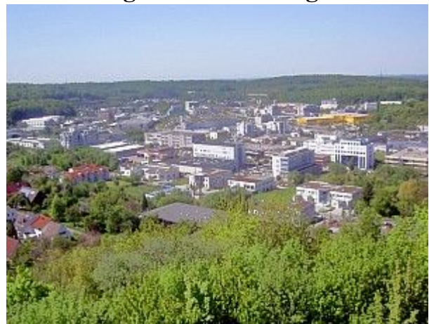
Gewerbegebiet Wilferdinger Höhe
