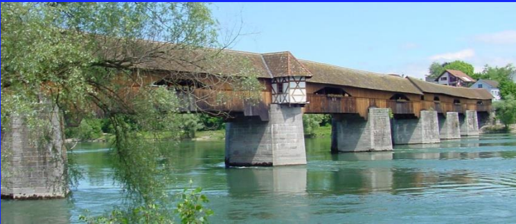
Die Rheinbrücke in Bad Säckingen (erbaut 1699)
