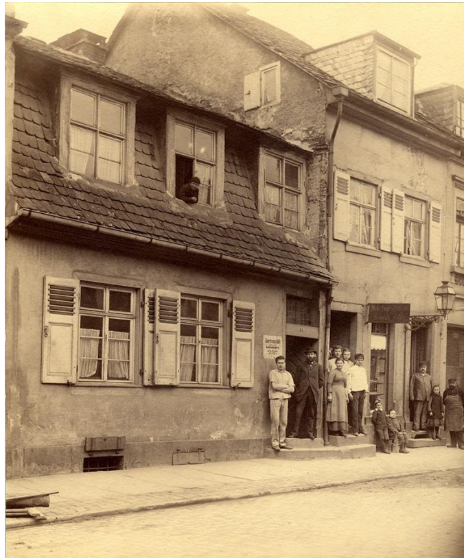
Modellhaus (einstöckiges Mansarddachhaus) nach den Bauvorschriften des Jahres 1715 in der Kronenstr. 14. Das Haus wurde 1880 abgerissen, das Foto ist kurze Zeit vor dem Abriss entstanden. © StadtAK 8/PBS XIVe 187.
