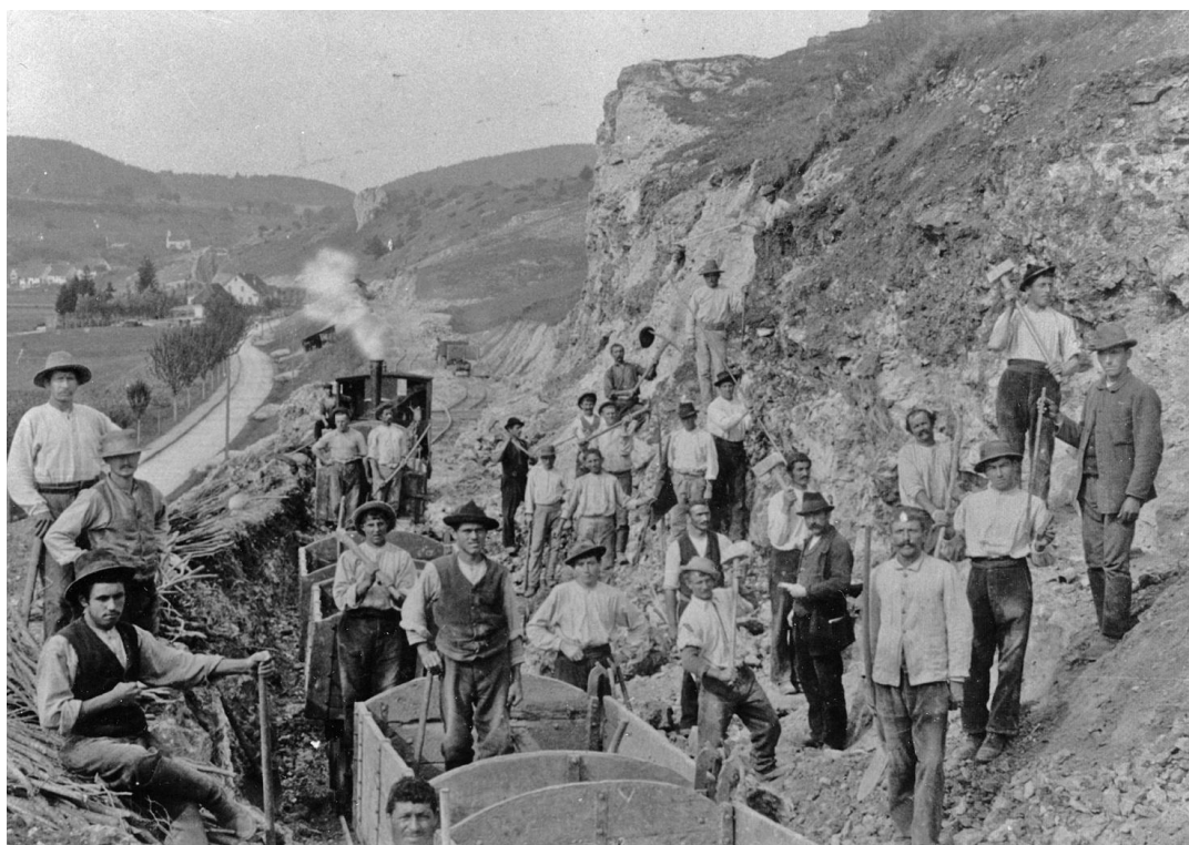
Feldbahn und italienische Arbeiter beim Bau der Hohenzollerischen Kleinbahn bei Bronnen auf der Strecke Gammertingen – Kleinengstingen, um 1901. (© Foto: Kreisarchiv Sigmaringen XI/8 – 2985)
