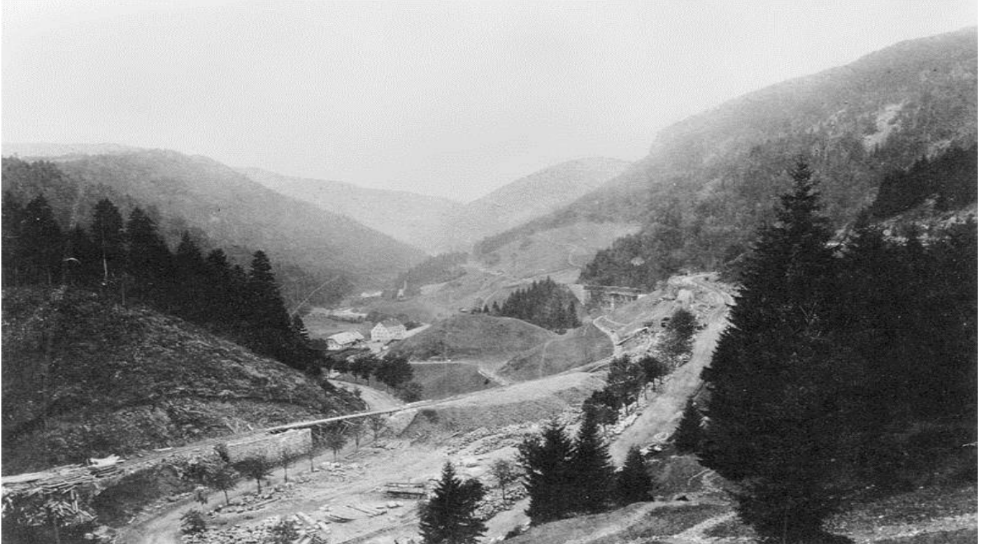
B1-2-a: Bau der Höllentalbahn von 1882 bis 1887 mit einer Steigung von 268m auf 885m auf 25,4 km Länge - hier Bau der Brücke vor dem Löffeltaltunnel (um 1886), Quelle: https://de.wikipedia.org/wiki/H%C3%B6llentalbahn_%28Schwarzwald%29#/media/File:Bau_der_Hoellentalbahn_um_1885_1-RZ.jpg , ©gemeinfrei
