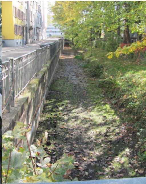
B2-4-f: Ableitung eines „Bächles“ vom Gewerbebach vor dem E-Werk, Quelle: Bömicke, ©Bömicke
