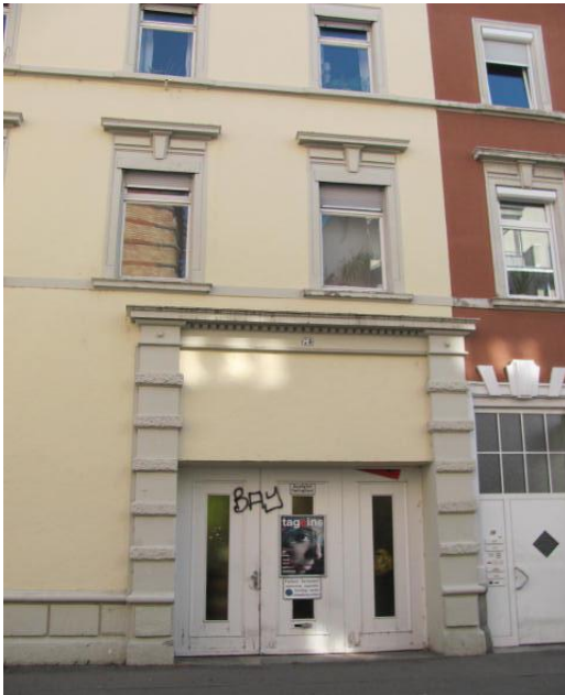
B2-4-i: typisches Reihenhaus im Stühlinger mit Gewerberäumen im Erdgeschoss, Wohnräumen im ersten Stock und Lagerräumen im zweiten Stock, Quelle: Bömicke, ©Bömicke
