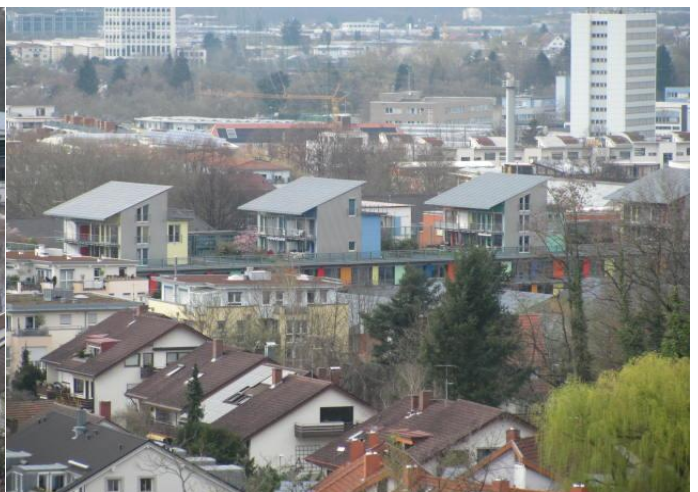
B4-1-f: Solarsiedlung „auf dem Dach“ – von oben, Quelle: Bömicke, ©Bömicke
