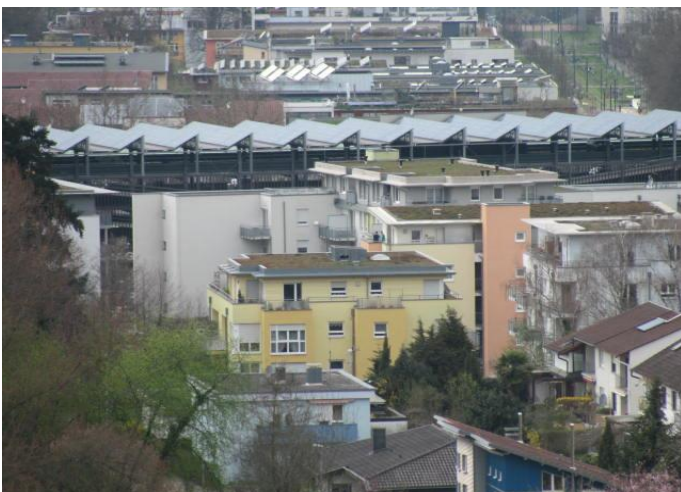
B4-1-e: Solargarage - Dach, Quelle: Bömicke, ©Bömicke
