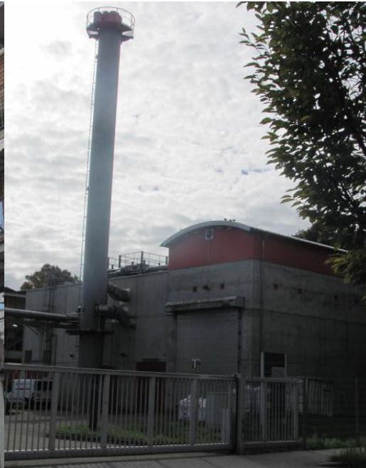
B4-1-j: Holzhäxelkraftwerk, Quelle: Bömicke, ©Bömicke
