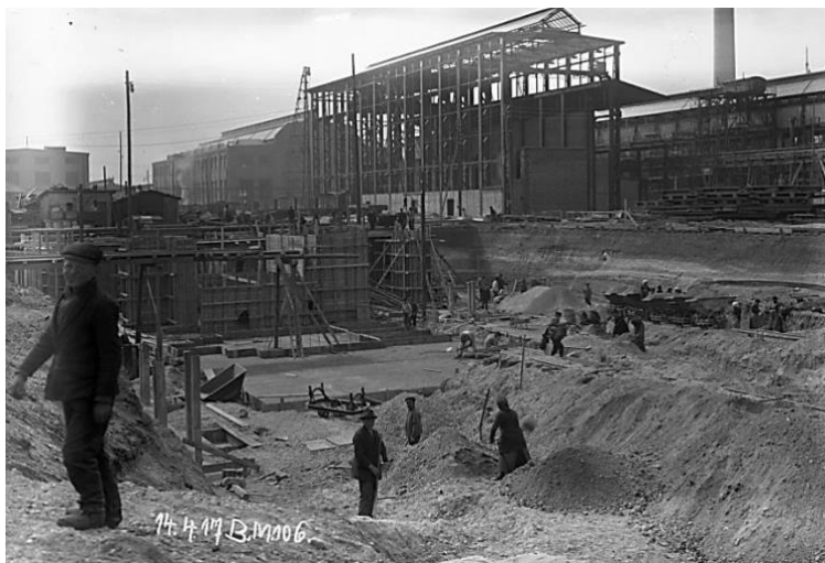
Kontaktofenanlage im Leuna-Werk im Bau © LASA Sachsen-Anhalt
