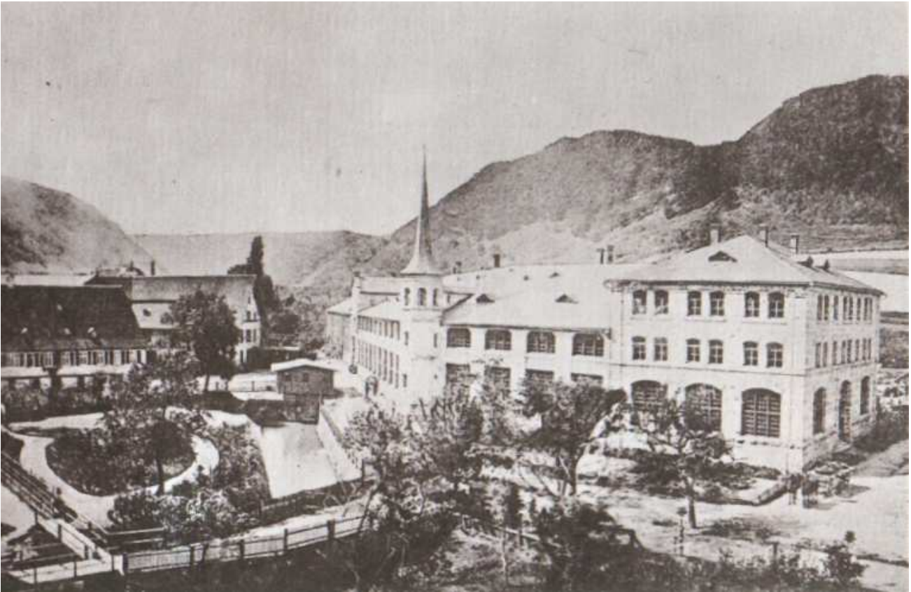
Die Maschinenfabrik Geislingen (MAG) um 1880. Links die Kapellmühle.
