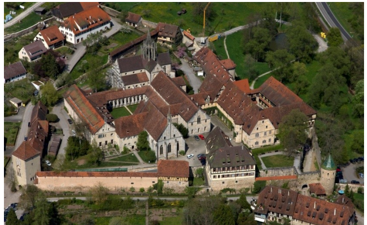
B1 Blick auf die Klosteranlage von Süden © Staatliche Schlösser und Gärten, Bebenhausen
