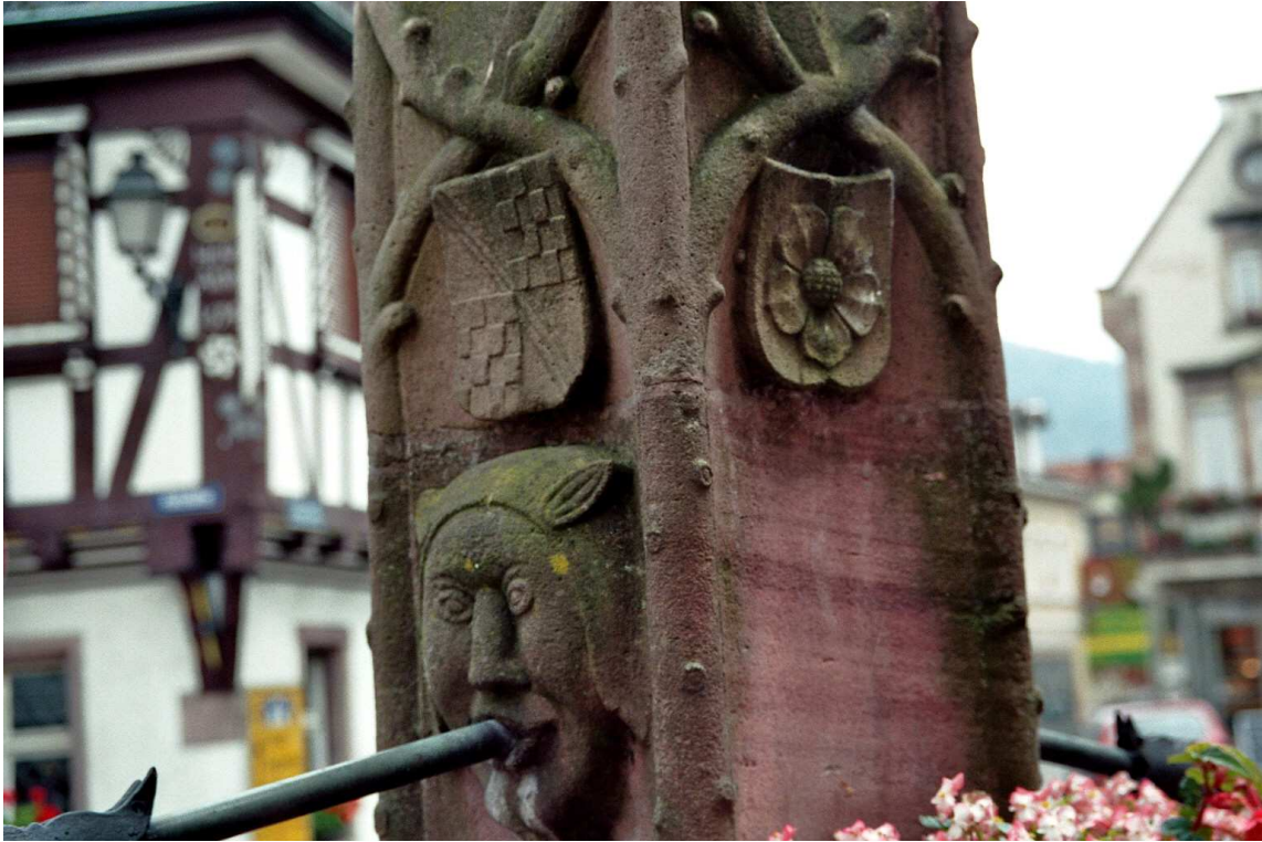
Der Hofstätte-Brunnen. Detailaufnahme. Erkennbar sind die Eckstäbe, das baden-sponheimische und das ebersteinische Wappen. © Rainer Hennl
