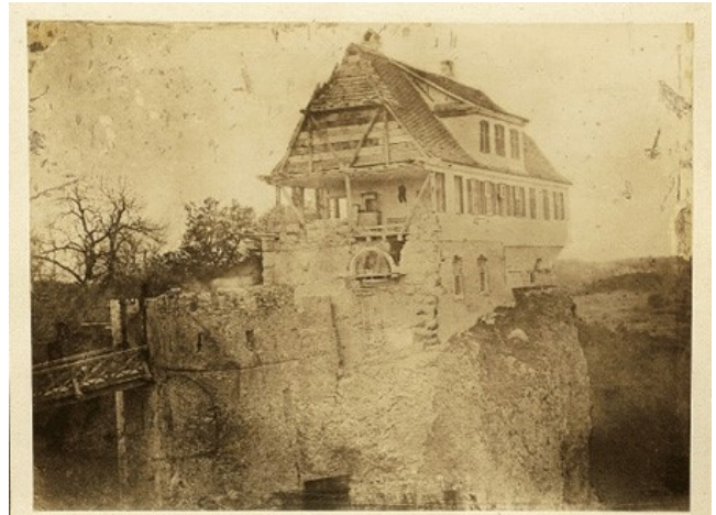
Abbruch des alten Forsthauses am Lichtenstein 1839
