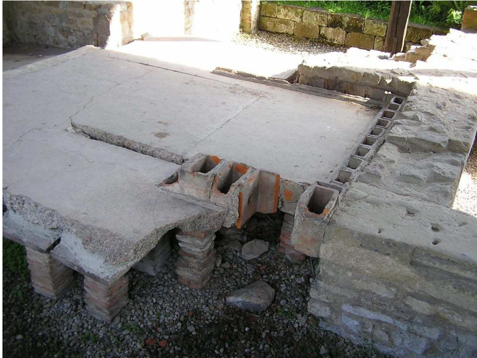
Wand- und Fußbodenheizung im Weinsberger Römerbad (Foto: Ulrich Maier)
