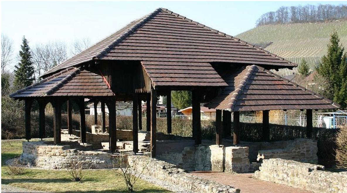
*Die Dachkonstruktion schützt nicht nur die konservierte Anlage, sondern sie zeigt auch die ungefähre einstige Höhe des Gebäudes an. (Foto: Wikimedia Commons)*
