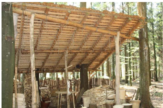
Für dieses Dach auf der Klosterbaustelle „Campus Galli“ wurden 1500 Schindeln benötigt.
