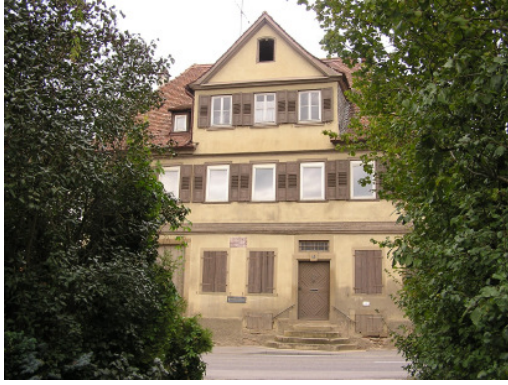
Wohnhaus der Familie Hölderlin in Lauffen. Mit großer Wahrscheinlichkeit das Geburtshaus Friedrich Hölderlins. (Foto: Ulrich Maier)
