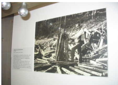
Ein Meiler wird errichtet © Museum Neuenbürg
