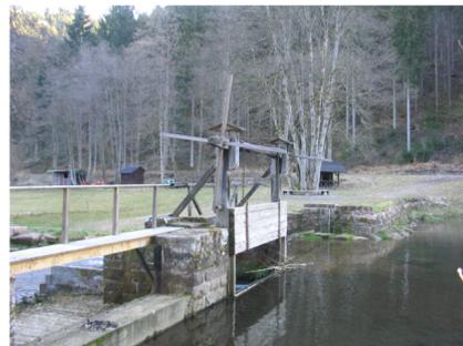
Die Seligenstube an der kleinen Enz oberhalb von Calmbach, angelegt als Schwellweiher oder Wasserstube zum Einbinden der Flöße sowie zu deren Abtransport. (alle Fotos © Hanisch)
