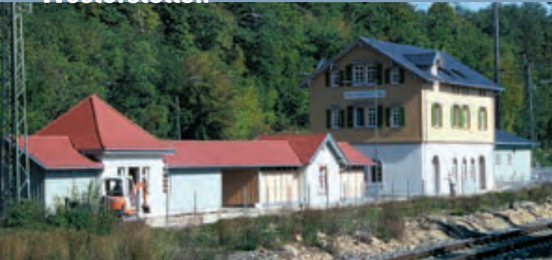
Alter Bahnhof Westerstetten
