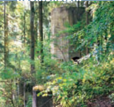
Trockenofen des Zementwerks
