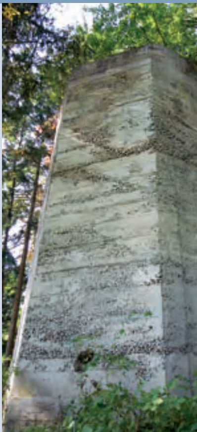
Trockenofen des Zementwerks
