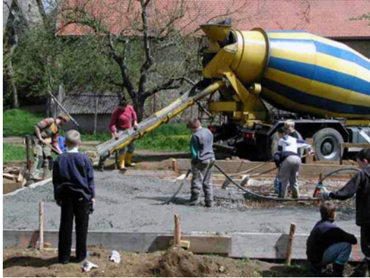
29 Betonierung des neuen Hühnerstalls
