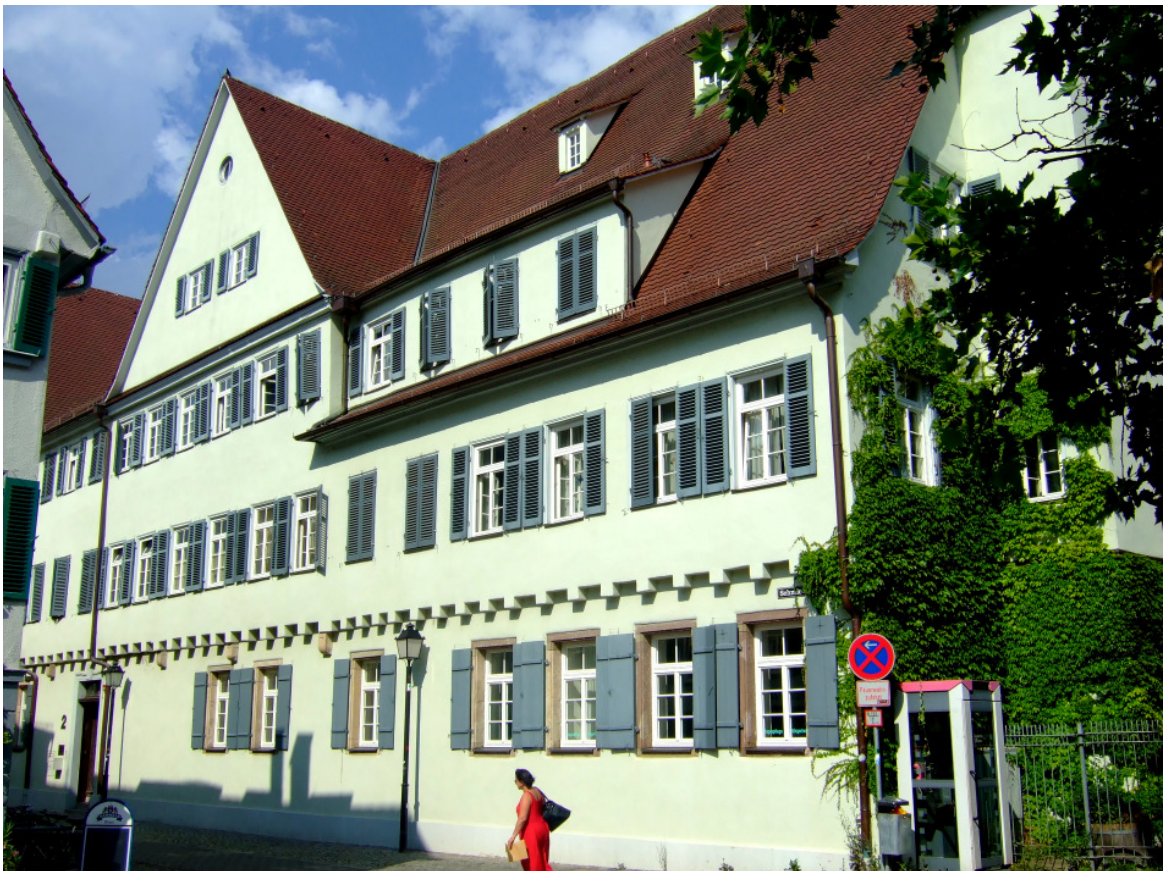
Das ehemalige Spital (heute: Altenzentrum „Bürgerheim“) (Foto R. Henes)
