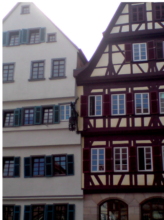
engstehende Fachwerkhäuser am Marktplatz (Foto R. Henes)
