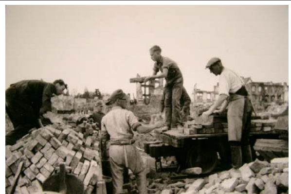
Abtransport „geputzter“ Backsteine
