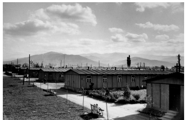
Bild 3 Lager Betzenhausen Außenansicht
