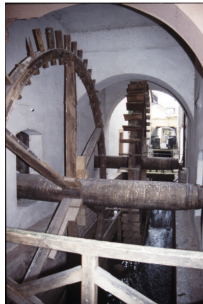
Wasserräder treiben das Pumpwerk an.
