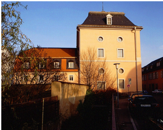
Gesamtansicht des Oberen Wasserwerks 1996
