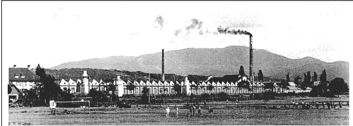
Fabrikgebäude der Ramie-Gesellschaft in Emmendingen, um 1930 (Foto Hirschmüller) © Stadtarchiv Emmendingen
