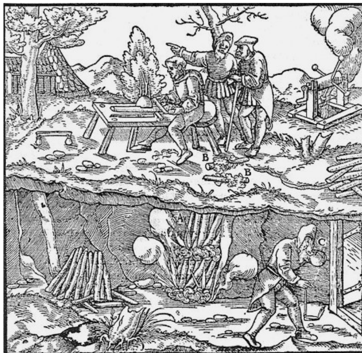
Feuersetzen unter Tage (B52)
