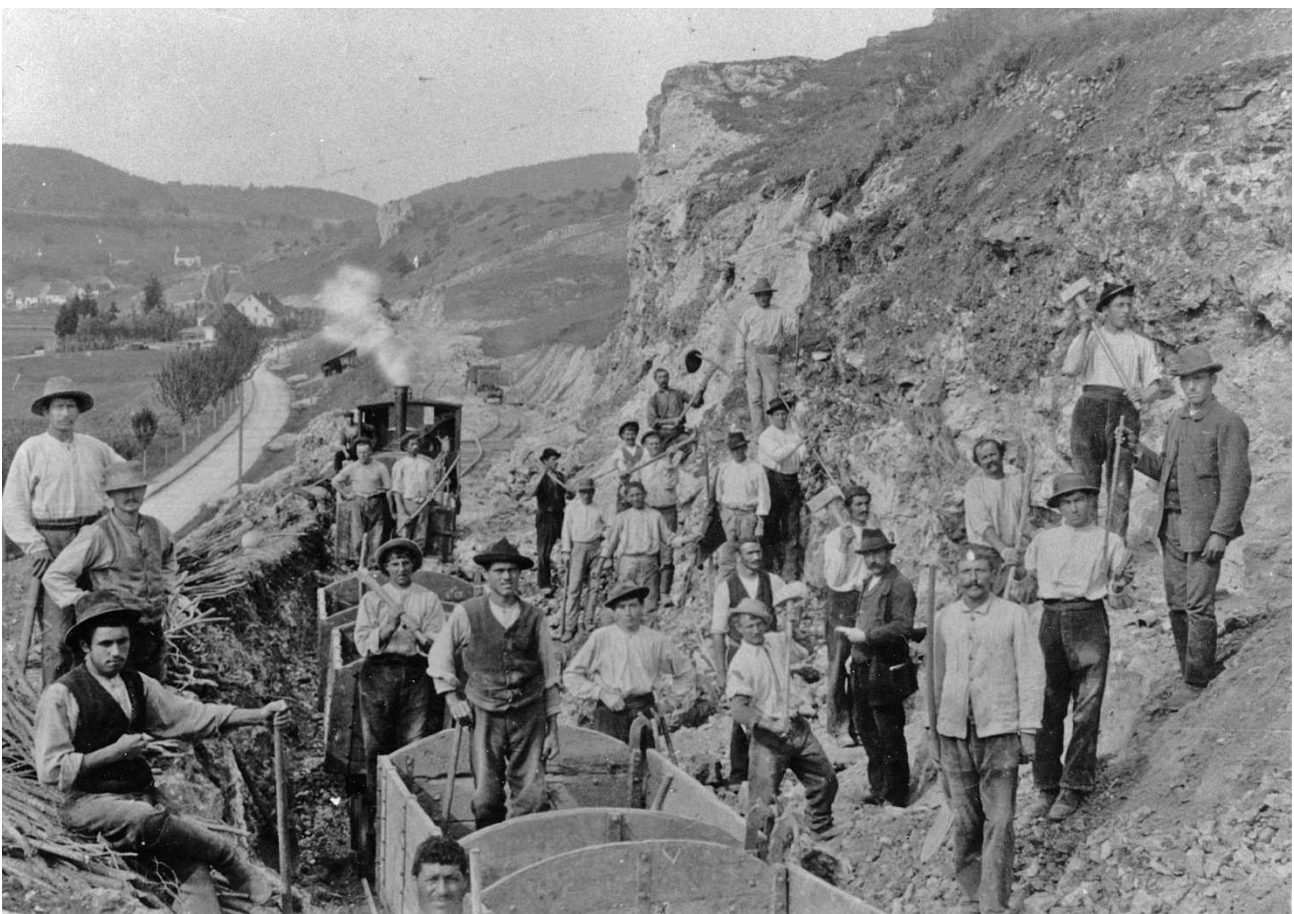
Feldbahn und italienische Arbeiter beim Bau der Hohenzollerischen Kleinbahn bei Bronnen auf der Strecke Gammertingen – Kleinengstingen, um 1901.
