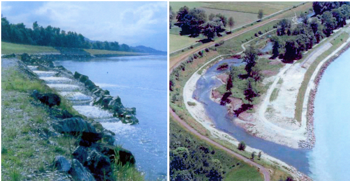
Abbildung 4 (Bild 12): erste Renaturierung des Liechtensteiner Binnenkanals: Beckenpass als technische Lösung für das Aufstiegshindernis bei der Mündung in den Alpenrhein.
