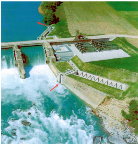
Abbildung 7 (Bild 15): Die roten Pfeile markieren Ein- und Ausstieg des Fischpasses. Der Einstieg wird von den Seeforellen problemlos gefunden.
