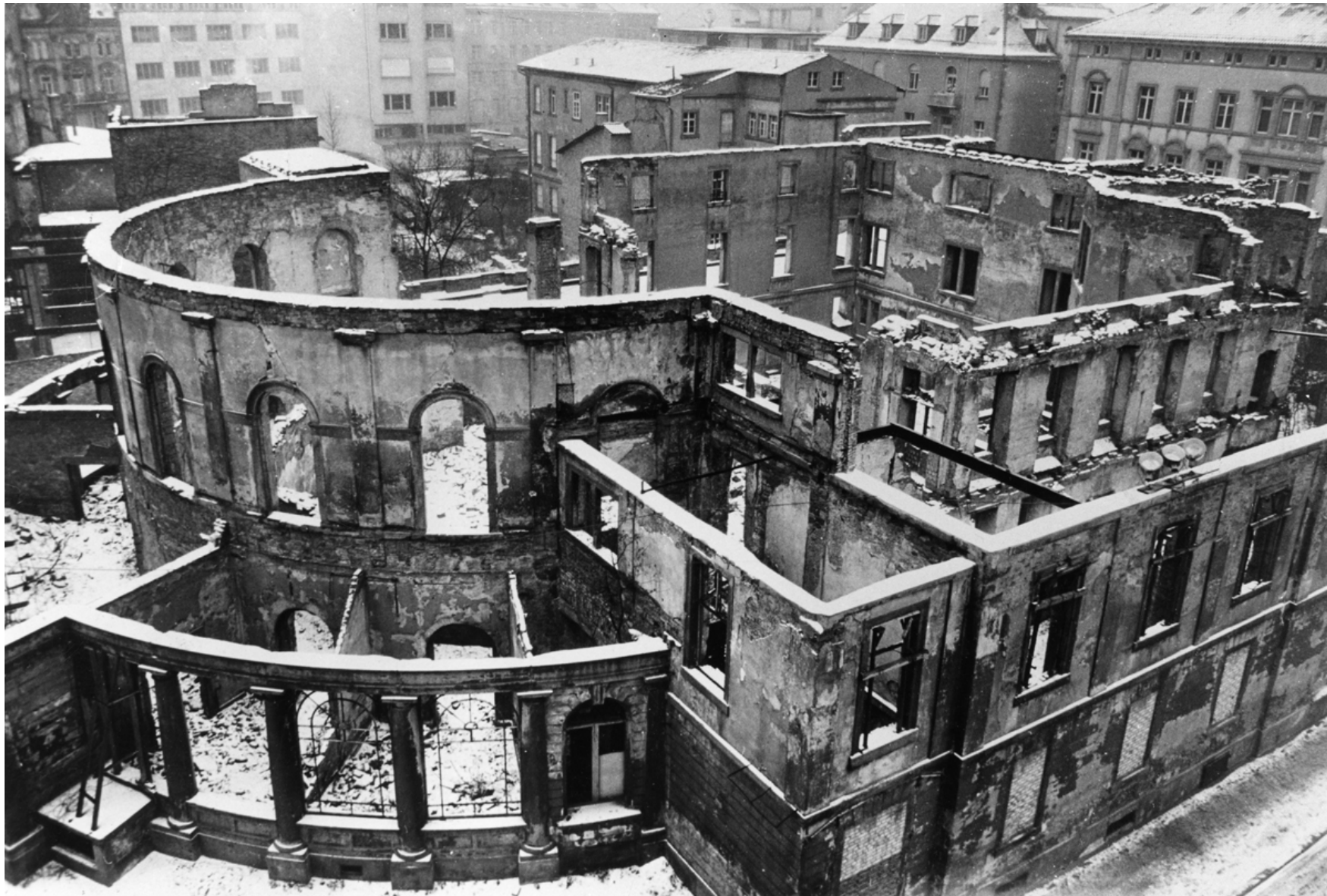
Fotografie der Ruine des Ständehauses, nach 1945. 1961/62 wurden die Ruinen des ältesten Parlamentsgebäudes Deutschlands abgerissen. © StadtAK 8/PBS XIVa-Plan-0694
